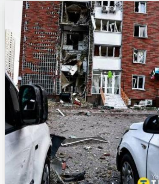
Мал. 6. Пошкодження новобудов з фасадом «Сканрок» в Києві від шахедних атак.
