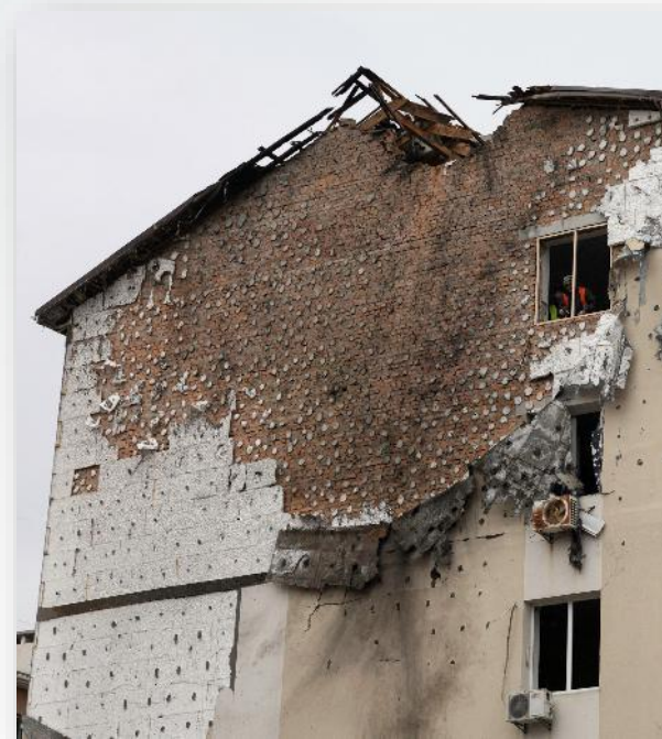
Мал. 12. Утеплення фасадів після руйнування
