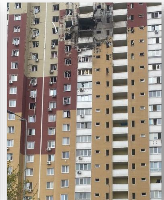
Мал. 6. Пошкодження новобудов з фасадом «Сканрок» в Києві від шахедних атак.
