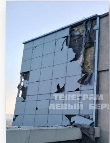
Мал5. Пошкодження керамічного фасаду в Києві від шахедних атак
